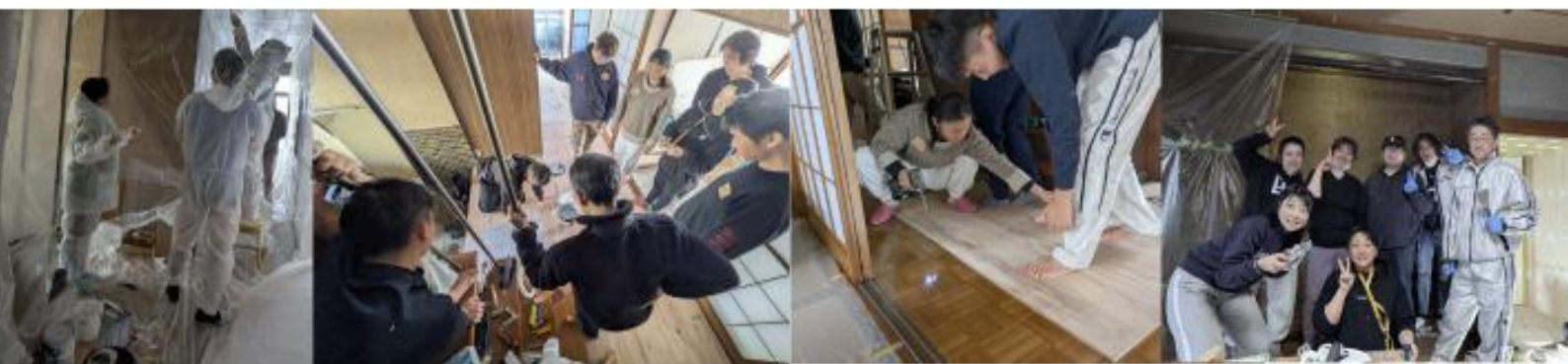
みんなで協力してワークショップで改修工事
